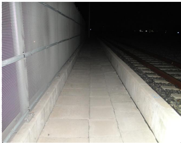
교량 상부 전경
