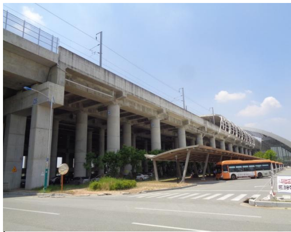
교량 측면 전경
